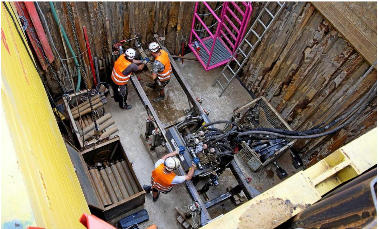
Mit einer sogenannten Vortriebsmaschine wird die Erde aufgebohrt, um später die Kanalarohre verlegen zu können. **Olaf Ostermann**
