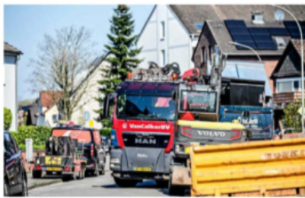
Die Straßen, auf denen die Arbeiten stattfinden, sind oft schmal. Einige Abschnitte müssen gesperrt werden.
